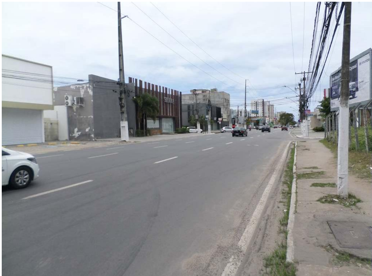
Figura 8.1.1.1 – Condições de acessibilidade na Avenida Almirante Álvaro Calheiros
